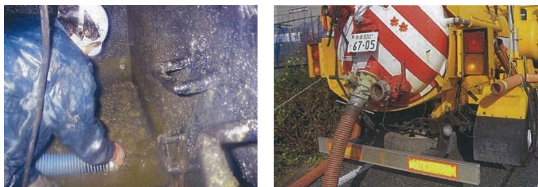
図3 伏越しマンホールの清掃状況
