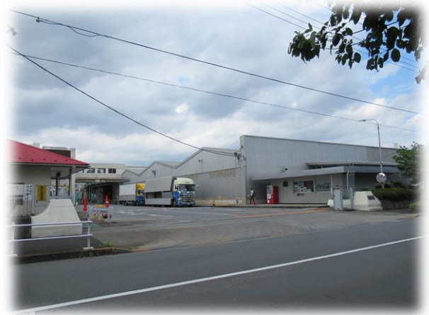
下里本邑通り沿道の工場
