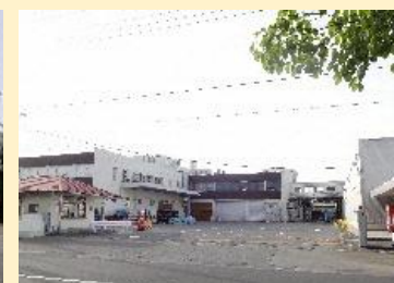
野火止一丁目の工場
