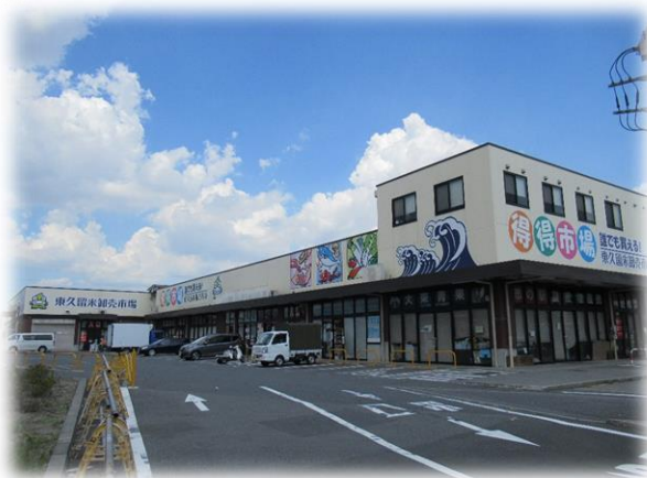
東久留米卸売市場
