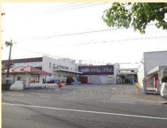
野火止一丁目の工場
