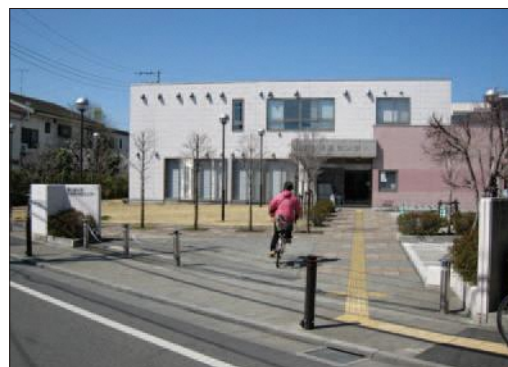
連続した視覚障害者誘導用ブロック (中央町地区センター)
