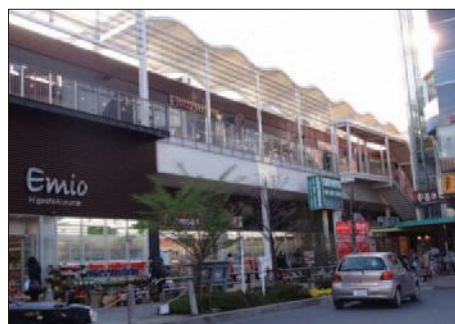
東久留米駅北口連絡通路
