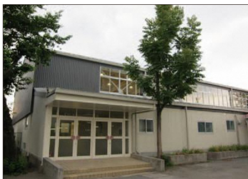
耐震化された公共の建築物 (神宝小学校の体育館)
