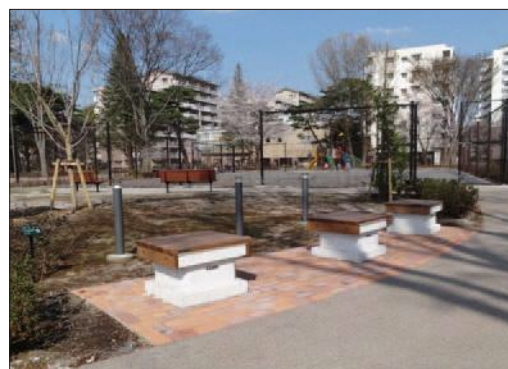
非常用トイレ体型ベンチ (ひばりが丘団地南公園)
