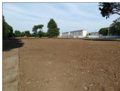
まちづくり重点地区 (更地化された住宅団地跡地)
