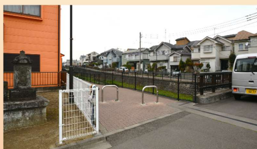
▲向かって右手側を落合川が流れている。車が通っているのは神明橋。
