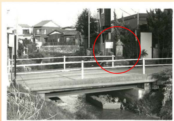
▲移設される前の様子。
