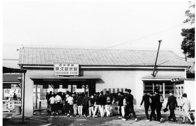
写真5 駅舎本屋増築後
